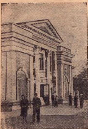
Сталинская область. На территории рабочего горька Енакиевского металлургического завода построено новое здание клуба, в котором имеется зрительный зал на 800 мест.
